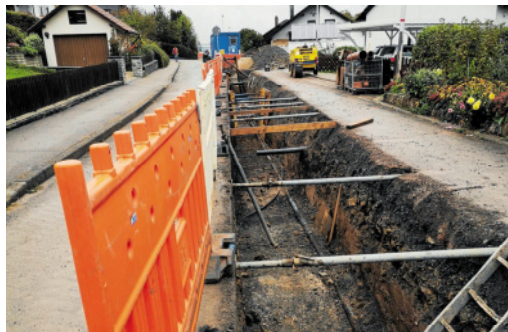
In der Lerchenstraße laufen die letzten Kanalsanierungen.
